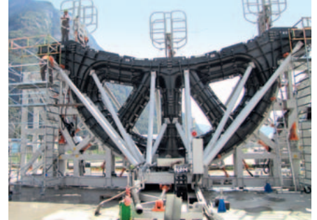
Betongussmaschine für die Tragstrukturen von CSP-Solarsystemen
