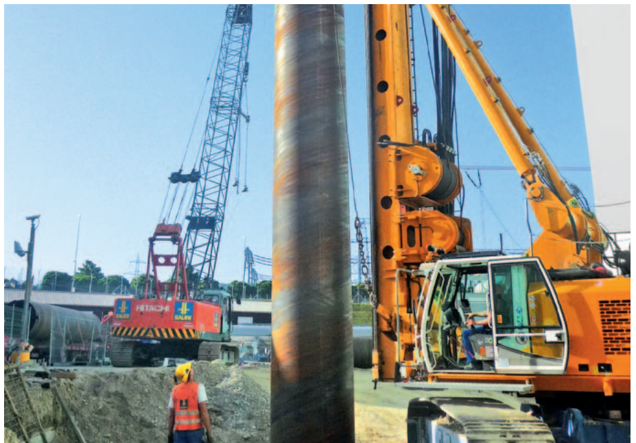
Kernkraftwerk Leibstadt, Bau einer Aktivlagerhalle, Projektleitung Bauherr
