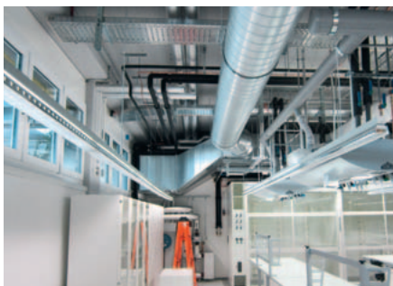
ZHAW Campus Reidbach, Ausbau Laborräume, Planung und Koordination Haustechnik
