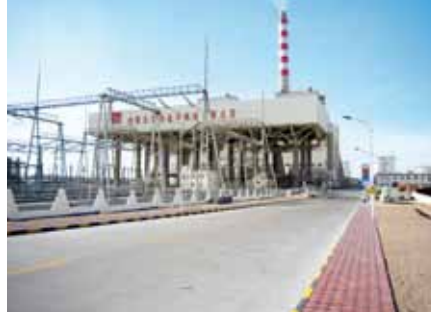
2 x 330 MW Kraftwerk für fossile Brennstoffe, Jinneng, Innere Mongolei, PRC
