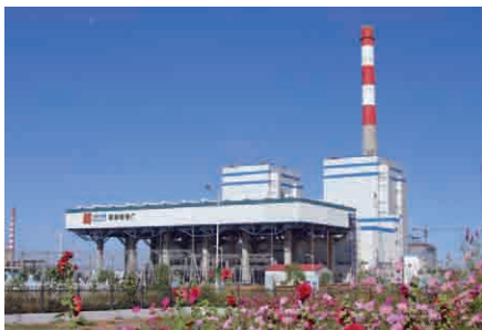
Neu erstelltes thermisches Kraftwerk Xilinhaote (2x300 MW) in China vor der Inbetriebnahme
